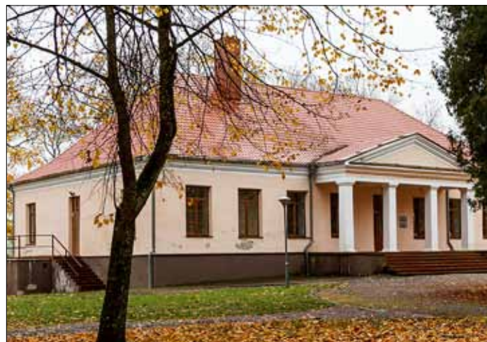
Obecnego wyglądu budynek nabratł po przebudowie w pierwszej połowie XIX wieku
