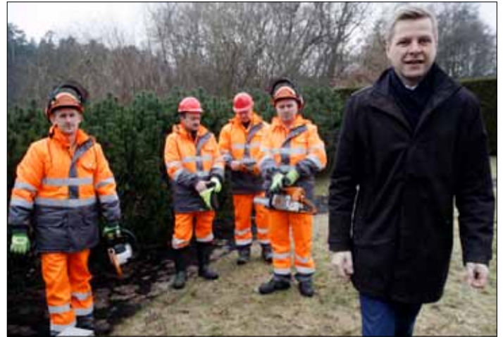
Wczoraj rano w Wilnie rozpoczęto rozbiórkę ogrodzeń nielegalnie postawionych na gruntach państwowych
